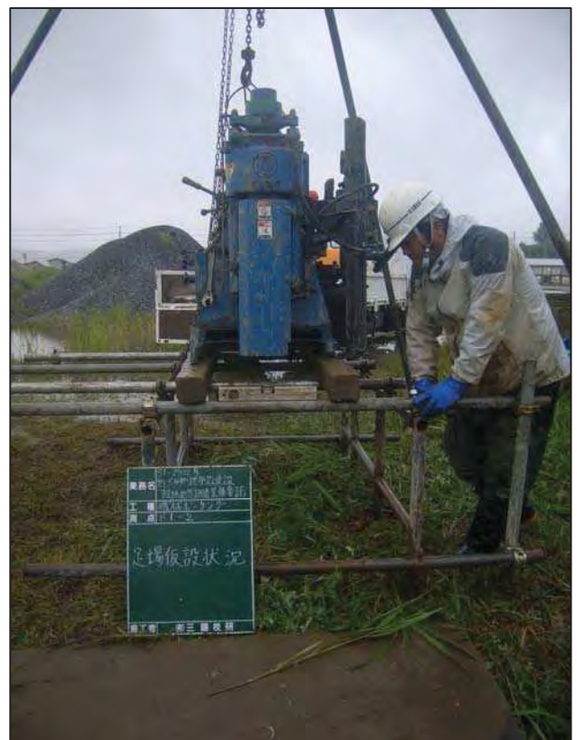
足 場 仮 設 状 況
