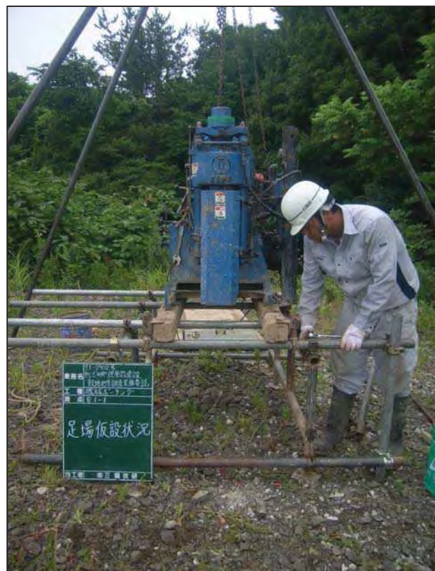
足 場 仮 設 状 況
